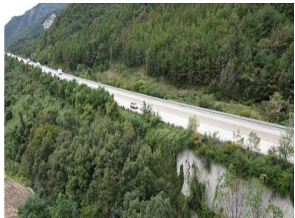
주변영향인자(성토부, 상부 본선) 상태현황
